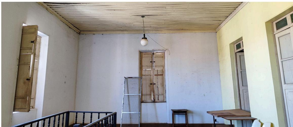
*Forros do segundo pavimento - peças soltas, manchas de umidade e partes apodrecidas*
