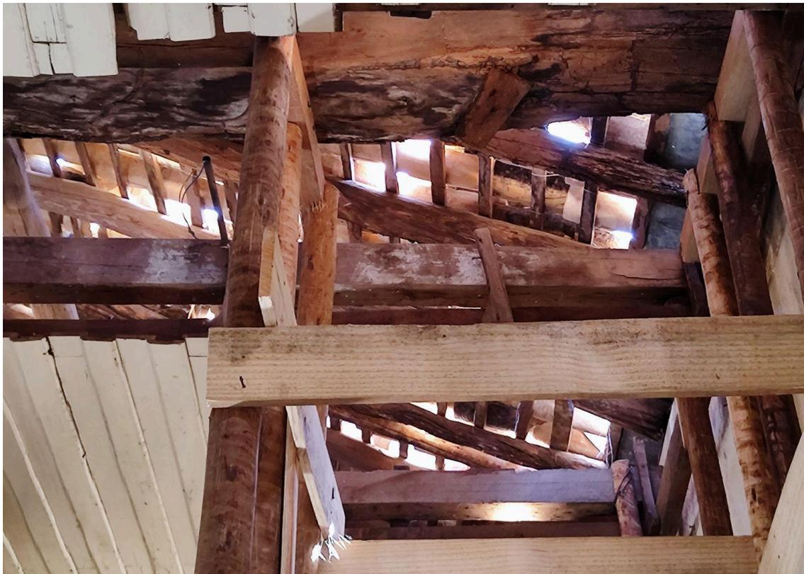
*Vista do telhado pelo trecho de forro removido - estrutura danificada e telhamento com peças soltas*
